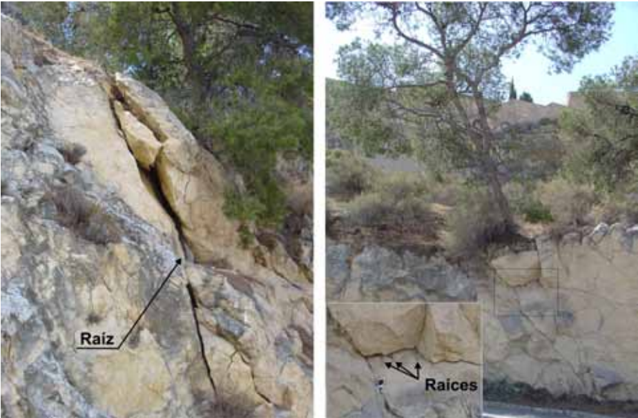
Figura 19. Ejemplos del efecto de crecimiento de la vegetación en el estado de las discontinuidades. Obsérvese cómo la apertura de las discontinuidades ha aumentado en las proximidades a las raíces.
