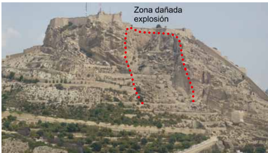
Figura 21. Vista panorámica del monte Benacantil en la que se ha señalado la zona dañada durante la explosión de 1709. Se observa la cicatriz en la parte superior, y la acumulación caótica de bloques que en su momento alcanzaron las zonas más bajas de la ladera (donde actualmente se encuentra el Parque de la Ereta y el casco antiguo de la ciudad).
