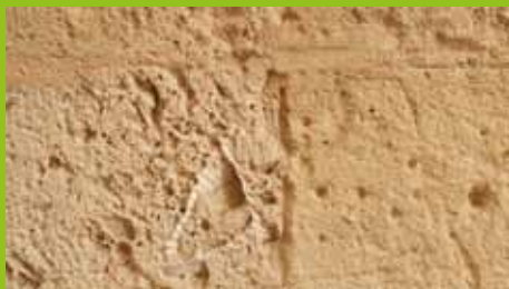
Figura 12 A. Molusco bivalvo incorporado en los sillares de la Basílica de Santa María, procedente de las calcarenitas del Mioceno extraídas en relieves adyacentes a la ciudad de Alicante. Se trata, en este caso, de un gran fragmento de la parte posterior de la concha del bivalvo en la que se aprecia la costulación en toda su superficie. Si observamos con atención, en todos los sillares se encuentran fragmentos milimétricos de estas conchas.
